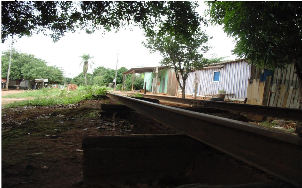
Foto 2 - Fragmentos da Estrada de Ferro Madeira Mamoré, vista no primeiro bairro constituído na cidade de Guajará- Mirim
